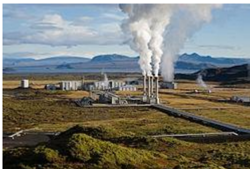
Centrale géothermique en Islande.
